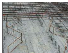
Pose des armatures sur écarteurs
