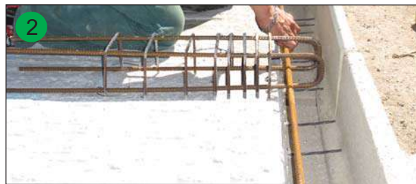
Mise en place des armatures du chaînage
