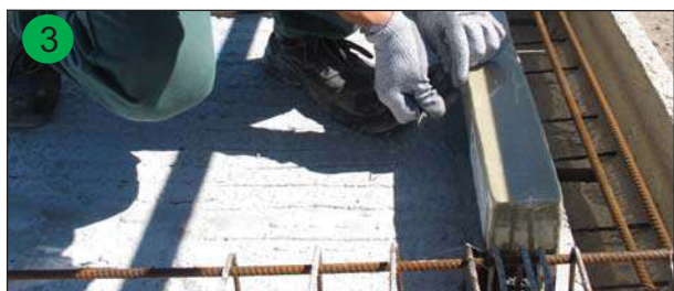
Positionnement et fixation du bloc isolant
