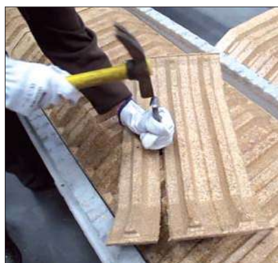
Coupe au burin ou au marteau (sécable)
