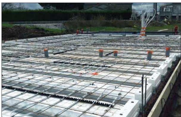
5. Pose des panneaux treillis soudés
