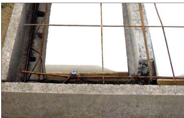
Plancher Hourdis Seacbois Rupteur Partiel : Stoptherm ES
