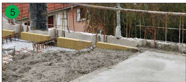
Coulage de la dalle de compression
