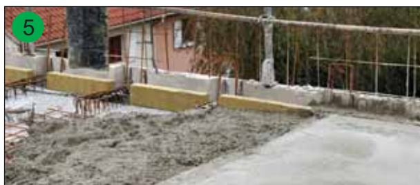
Coulage de la dalle de compression
