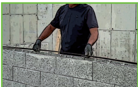
10 Positionnez les armatures horizontales dans les réservations.
