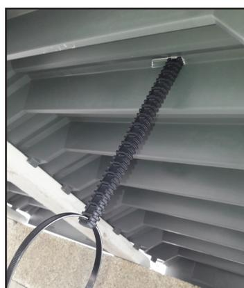
La légèreté, la longueur de l'entrevous (1,25 m), l'entraxe (0,63 m), la facilité de coupe et le bouchon incorporé permettent de poser un plancher en un temps record en s'adaptant aux différentes configurations. Le PlastiVS étant pré-percé, la mise en œuvre et le réglage des suspentes sont facilités. En effet, la tige de la suspenste VS se maintient dans le hourdis et permet un réglage précis des canalisations avant le serrage définitif.
