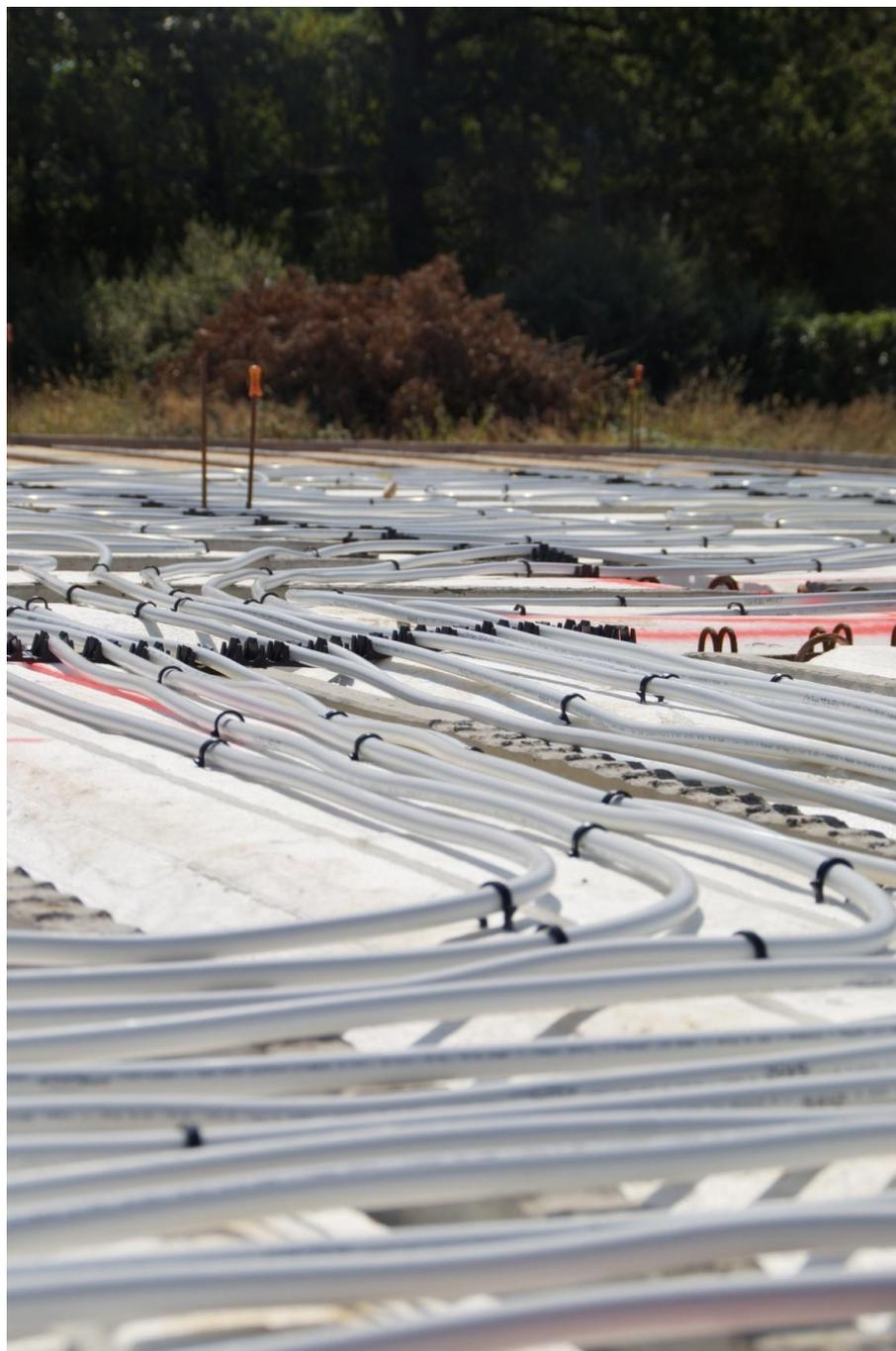
**GUIDE DE POSE DES TRAMES DE CHAUFFAGE AU SOL**
