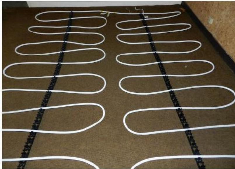
*Enfin, détacher, dérouler et fixer les raccordements Aller et Retour (Rouge et Bleu) jusqu'à l'emplacement du collecteur en respectant le plan de préconisation de pose.*
