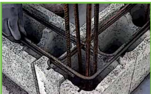
**5** Positionnez les étrépages de ferrailage pour assurer la continuité des armatures dans les angles.
