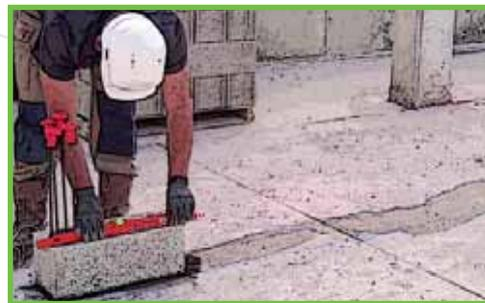
**13** Une fois l'altimétrie contrôlée entre les deux blocs, vérifiez l'aplomb et le niveau de votre deuxième bloc. Recontrôlez l'altimétrie au besoin.
