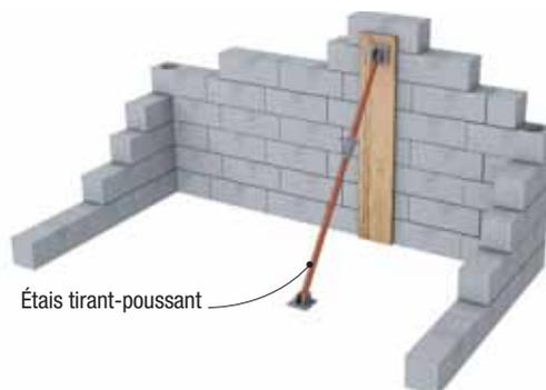
Après montage du mur, les blocs de rive sont découpés à la pente voulue soit au moyen d'une scie à disque ou à lame après montage de l'ensemble des rangs, soit par découpe des éléments avant leur montage en visant à limiter la section de dressement du rampant.
