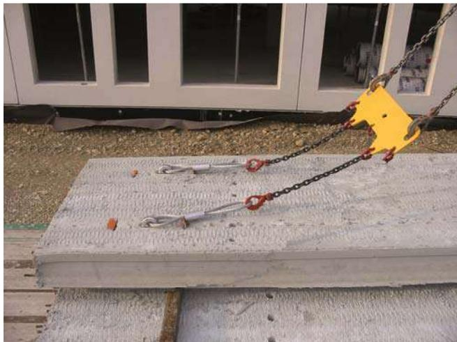
Le système de levage intégré aux dalles alvéolées SEAC ne nécessite par la mise en place d'une chaîne de sécurité passant sous la dalle.
