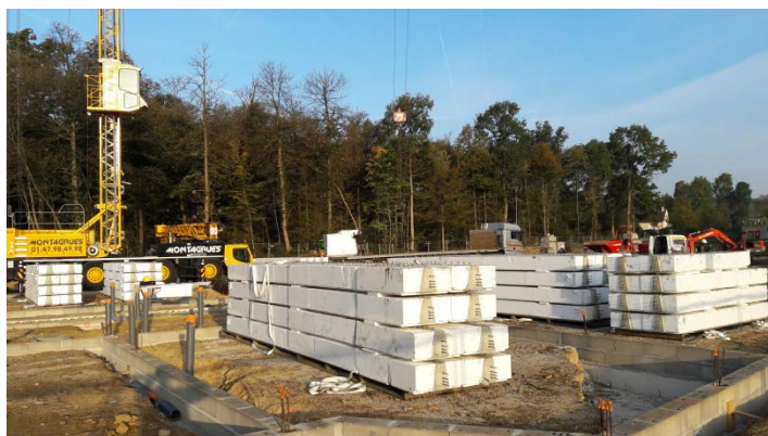
Les palettes sont à stocker près du lieu de pose
