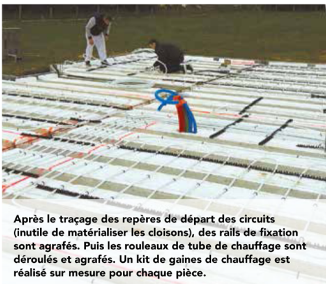
Pose du plancher Seacwatt : les réseaux eau et électricité sont traités en plenum.
