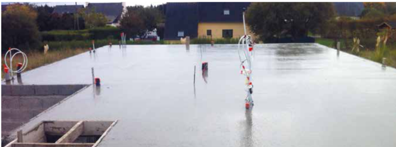
Une dalle de compression en béton de 7 cm, coulée sur les hourdis, noie le réseau de tubes. Après séchage, elle accueillera directement le revêtement final.
