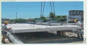
Mise en œuvre du système Seacisol : une dalle isolante permettant la réduction du volume de béton nécessaire pour la confection d'un plancher.
