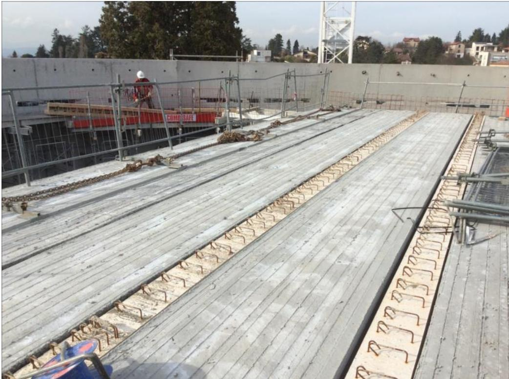
Mise en œuvre de poutres précontraintes section 30x50, portée 15.80 ml.
