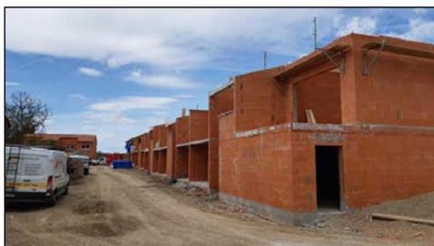
Système Seacoustic : ne nécessite pas d'installation de grue de chantier
