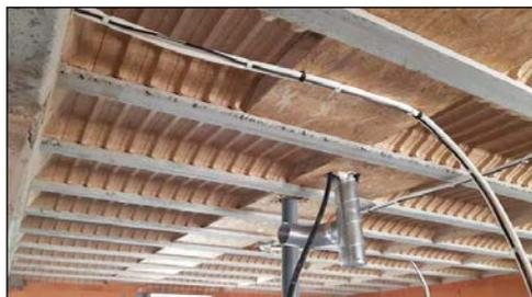
Gestion des SAD (acoustique entre les mur et le plancher) grâce au SEACBOIS négatif
