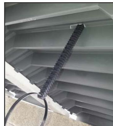
La légèreté, la longueur de l'entrevous (1,25 m), l'entraxe (0,63 m), la facilité de coupe et le bouchon incorporé permettent de poser un plancher en un temps record en s'adaptant aux différentes configurations. Le PlastivS étant pré-percé, la mise en œuvre et le réglage des suspentes sont facilités. En effet, la tige de la suspente VS se maintient dans le hourdis et permet un réglage précis des canalisations avant le serrage définitif.
