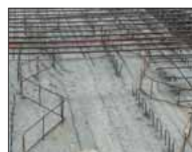
Pose des armatures sur écarteurs
