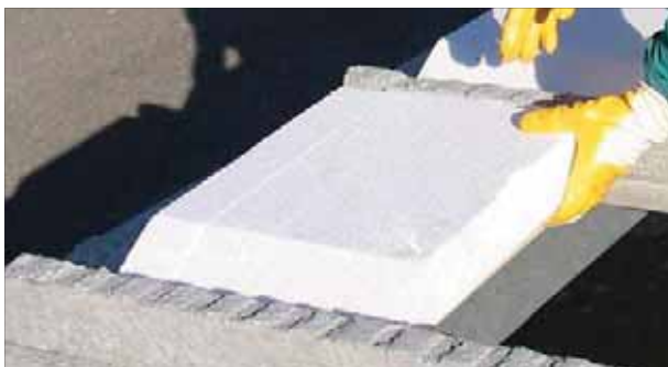
Chute utilisée pour commencer la travée suivante
