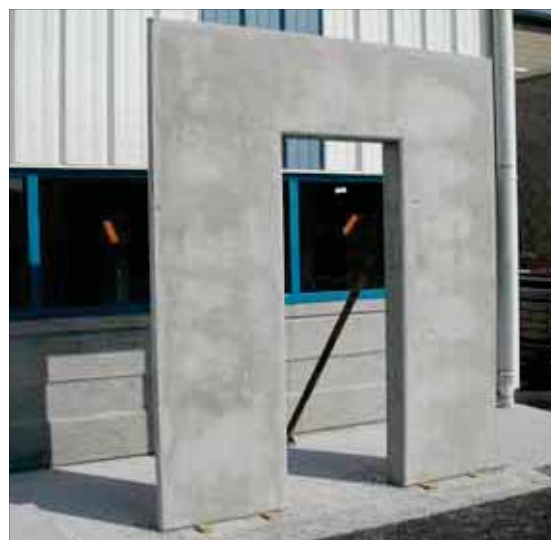
Coffrage avec chant en béton de fibre
