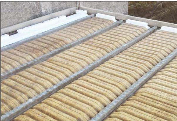
En transversal : plancher EBS et Rupteur Stoptherm EBT. La mise en œuvre est simplifiée grâce au jeu de pose de l'EBS et à sa secabilité tous les 10 cm.
