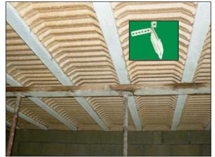
de place dans le plénum car les nervures ne mesurent que 3,3 cm. Le plénum est augmenté de 8,7 cm pour un plancher de 12+5 cm et de 11,7 cm pour un plancher de 15+5 cm.
