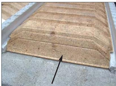
Bouchon incorporé et sécable
