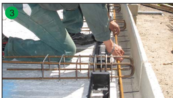
Mise en place des armatures
