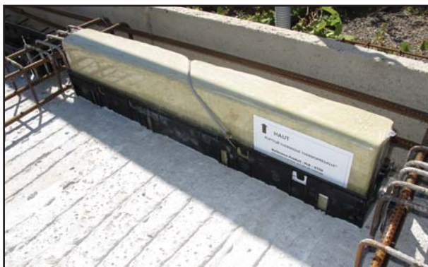
Mise en place du bloc isolant
