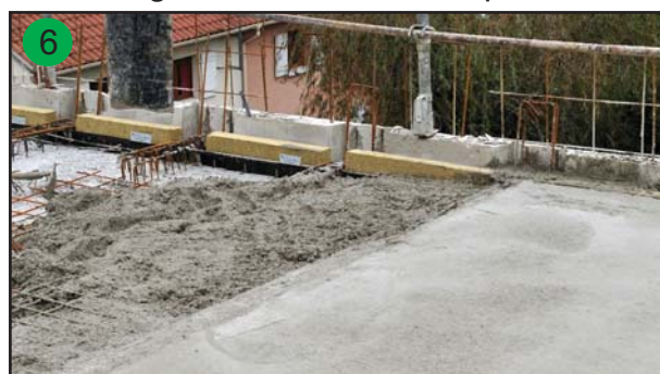
Coulage de la dalle de compression
