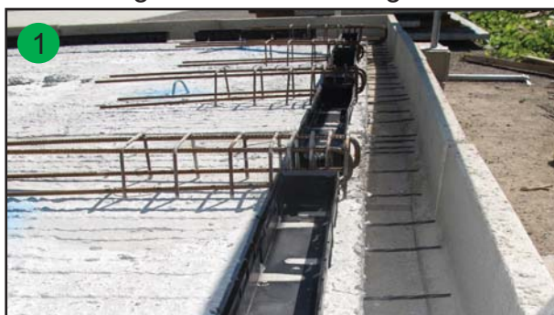
Pose de la Thermoprédalle avec ses cages d'armature intégrées
