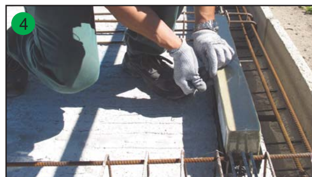
Positionnement et fixation du bloc isolant
